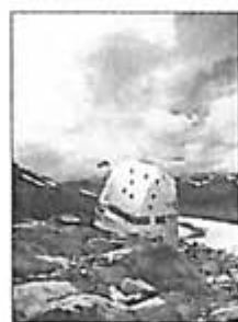
La nouvelle cabane du Mont-Rose et sa surprenante architecture.
